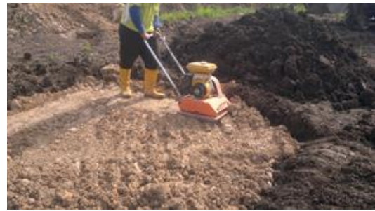
Gambar 3 Kerja-kerja memadatkan tanah menggunakan pemadat tanah
