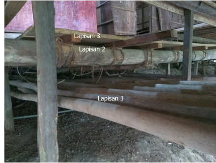
Foto 6 Tiga lapisan pentas lansaran . Lapisan 1: Bahagian bawah (Batang kayu) Lapisan 2: Bahagian tengah (Batang kayu) Lapisan 3: Bahagian atas (Papan) Gambar diambil oleh pengkaji di rumah tradisional Murut, Muzium Negeri Sabah, Kota Kinabalu, 21 April 2017
